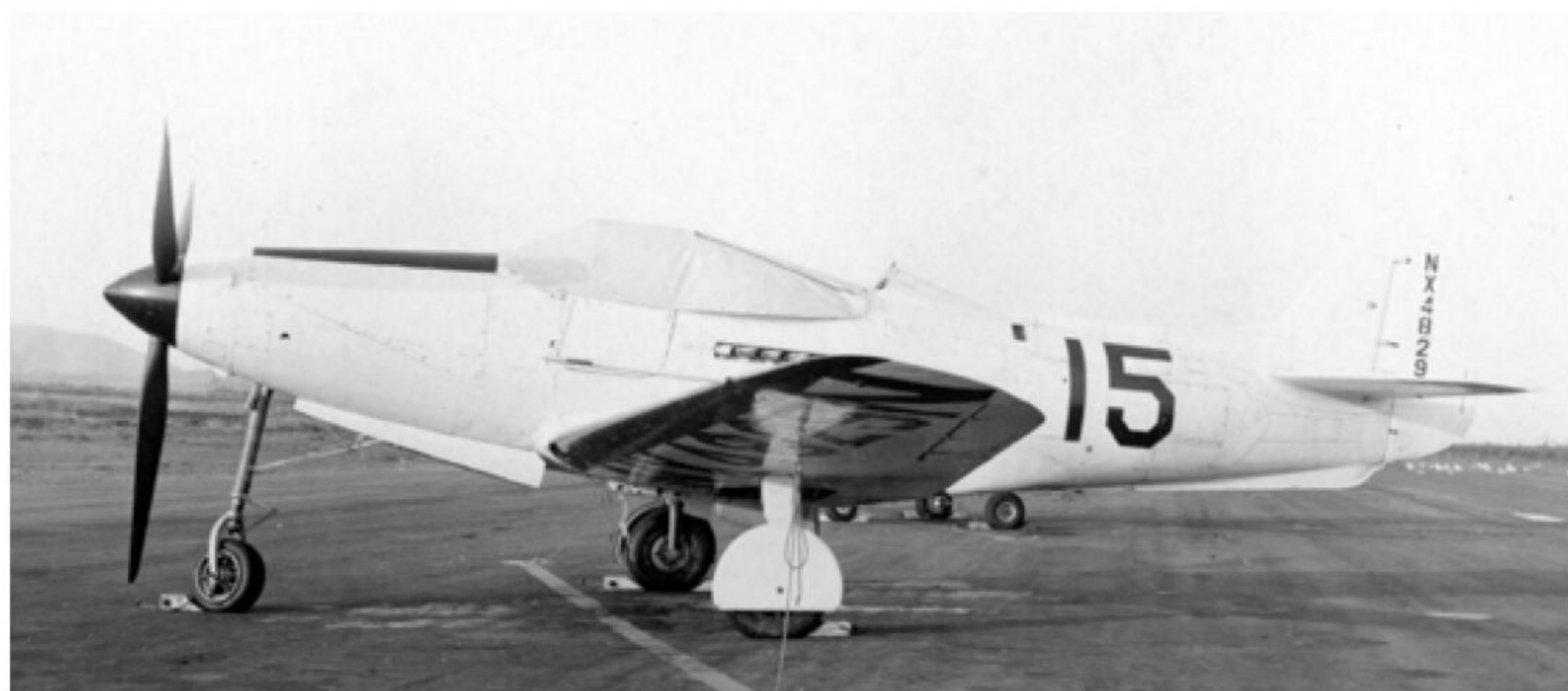
Zu den häufigsten Änderungen an den P-63 gehörten gekürzte Flächen und die Anbringung einer Finne unter dem Rumpf zur Stabilisierung.
