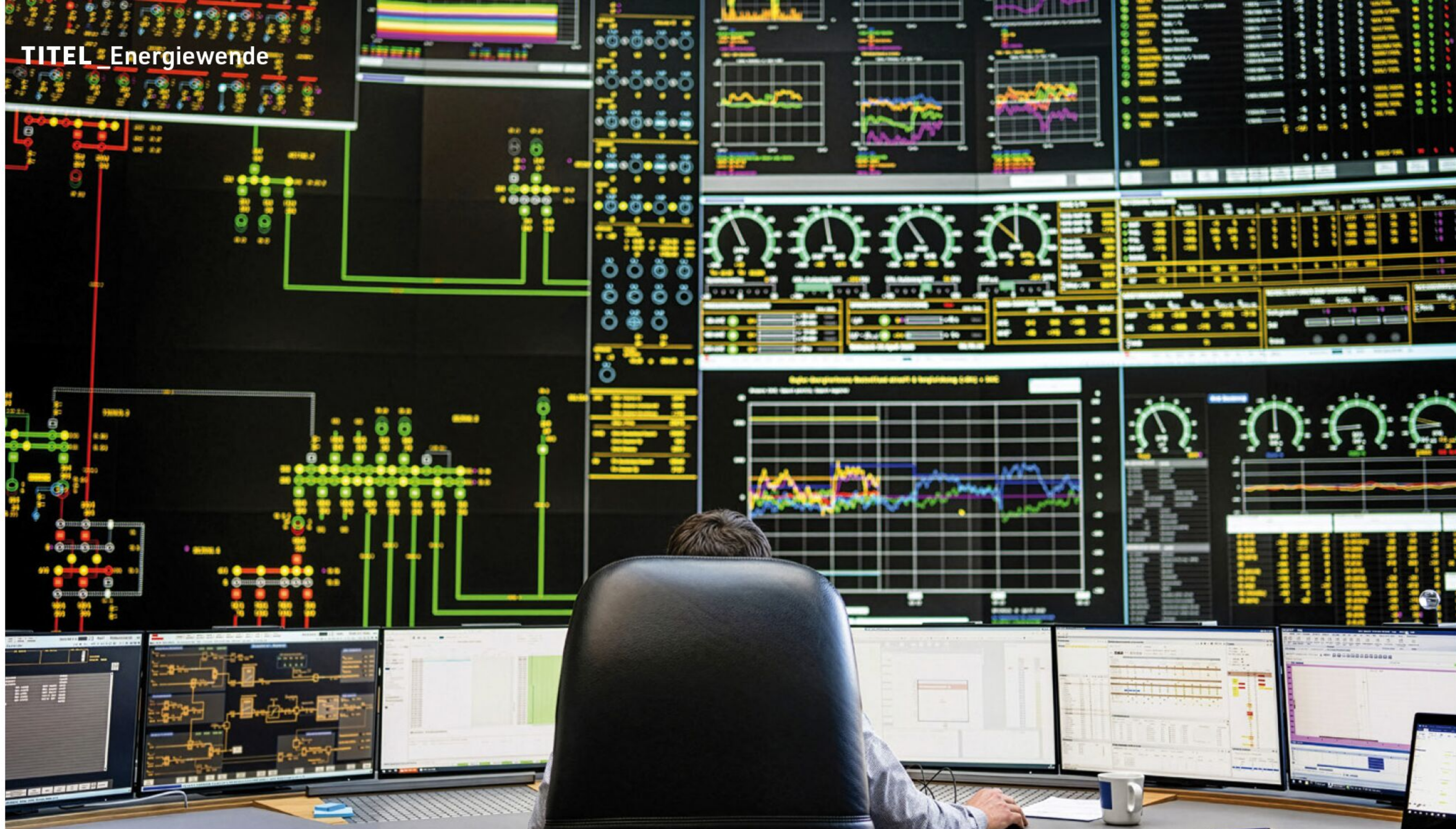
Alles im Blick: In der Hauptschaltleitung des Netzbetreibers Amprion sehen die Beschäftigten, welche Kraftwerke gerade wie viel Strom ins Netz einspeisen und welche Leitungen welchen Anteil davon übertragen.
