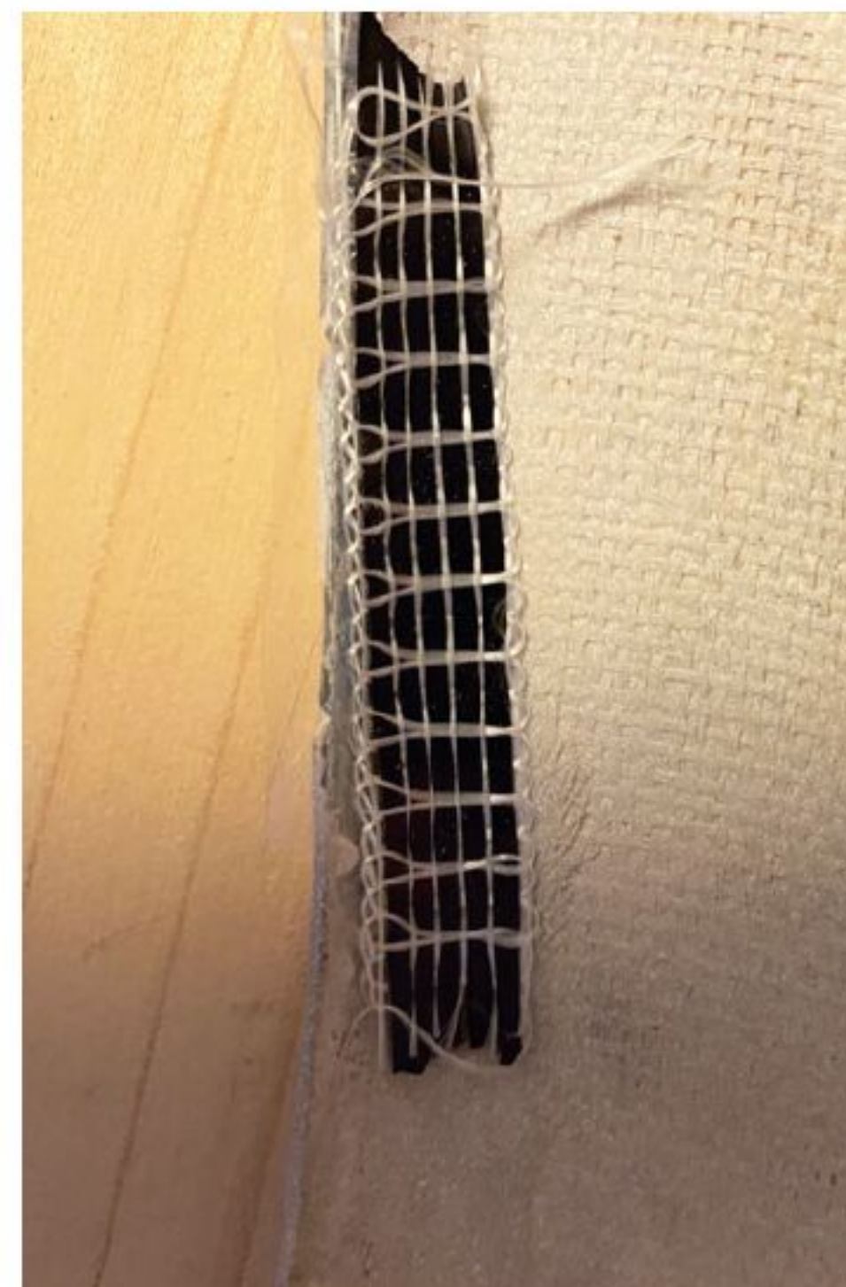
So sieht die Reparatur eines Haubenrandes mit Carbonband aus.
